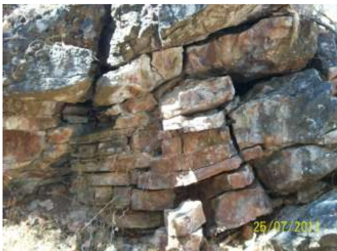
Foto 01 – Blocos de quartzitos na área de acesso da Gruta da Lagoa Azul, na porção que compõem a área de montante do teto da caverna, intensamente recortadas por sistemas de fraturamentos atectônicos. Há riscos de rolamento destes blocos para o interior das cavernas Fonte: João Nogueira
