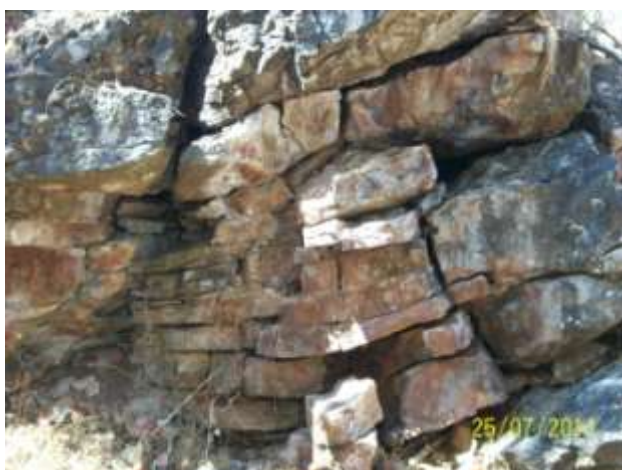
Foto 17/III – Blocos de quartzitos na área de acesso da Gruta da Lagoa Azul, na porção que compõem a área de montante do teto da caverna, intensamente recortadas por sistemas de fraturamentos atectônicos. Há riscos de rolamento destes blocos para o interior da caverna
