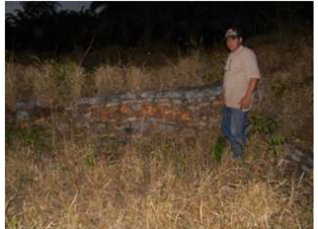
Foto 115/III - Muro de pedras encaixadas
