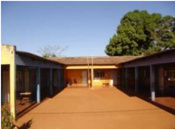
Foto 49/III – Escola de Coqueiral
