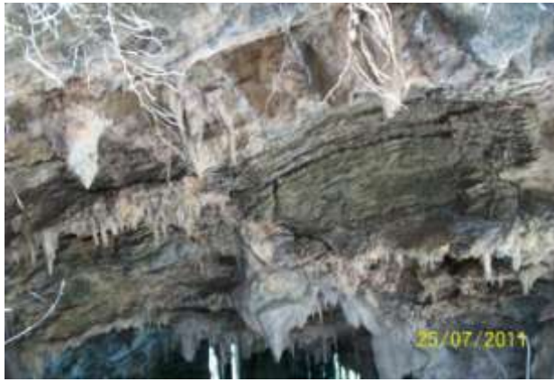
Foto 19/III – Detalhe da foto anterior mostrando fraturas atectônicas abertas (seta) na parte interna do arco
